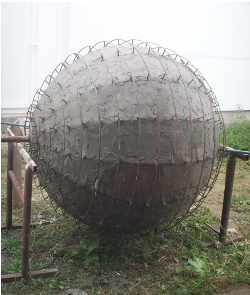
Слика 10: Жичана конструкција глобуса израђена у радионици архитекте Драгољуба Паје Милутиновића у Шапцу. На ову жичану конструкцију је нането 7 слојева фeroцементa.
