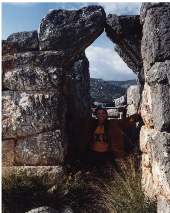
Слика 2: Улаз у Хеленикон пирамиду са источне стране. Улаз је код југоисточног угла. Ширина му је 1.35 м, док се његов врх састоји од два конвергирајућа камена који чине велико грчко слово Λ.
